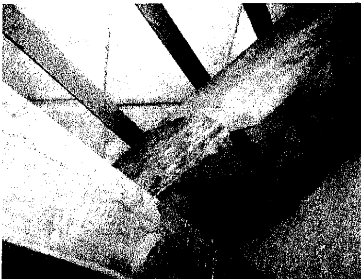
9. kép: szarufák helytelen toldása
